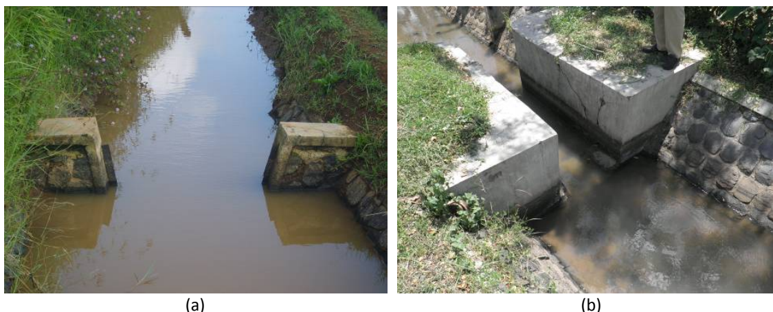
Gambar 2 Alat Ukur Cipoletti (a) dan Ambang Lebar (b) yang Dirusak Karena Dianggap Menghambat Aliran
